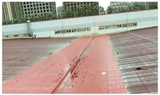
一、聚脲涂料特点:聚脲是当今世界上超前的防腐蚀、防水、耐磨等特种防护涂料,所有特点总结一句话,只要刷好就可以用一辈子不出问题。二、材料没问题,因此只要刷好就万事大吉了。要刷好,就是两点: 1. 刷均匀。具体包括以下几个方面: ①刷前搅拌均匀,因为重的成分会沉底,就这么简单。②如果是双组份的,分别在原桶搅拌均匀后按比例倒在搅拌桶里搅拌均匀。③涂刷的时候刷均匀,不能有该刷而没刷到的地方,同时尽量做到厚度均匀,不要厚的地方厚死,薄的地方薄死。2. 不要脱落。聚脲涂料本身的粘结性特别好,同时配有底漆,不会由于自身原因造成脱落。因此,需要确保的就是基层清理好,所有影响粘结的因素去除得越彻底,越牢靠。要是刷在一层沙子或者一层油上面,自然有脱落的隐患。基层不要起沙,不要有很厚的灰,不要掉皮,不要有油污,尽量除锈等等。
