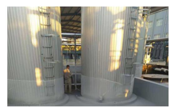
涂层保护:①施工过程中聚脲涂料、底涂应贮存在库房内,严禁雨淋、日晒(详细的贮存保管应按供货单位相关技术说明)。②底涂涂刷完毕要保护,不允许随意走动或进行其他作业,必要时应整体遮盖,防水沾污和灰尘影响聚脲涂层与底涂层的粘结力。③聚脲地坪施工完毕24小时内应注意保护,不允许进行其他作业,以免造成污染。④避免涂层与无机酸、有机酸的氯化物、醛类、酮类、胺类化合物等化学介质长期接触。⑤避免尖锐物体对涂层的剪切破坏。⑥特别说明:后续安装其他附件时必须注意避免尖锐物体对涂层形成剪切破坏!质量验收标准①聚脲层外观检测:聚脲层表面平整、无流挂、无起泡、无空鼓、无开裂、无异物混入。②厚度检测:可用便携式超声波测厚仪检测聚脲层厚度,平均厚度不能小于设计厚度。山东德士力新材料科技有限公司以快的速度提供好的产品质量和好的价格及完善的售后服务。陕西矿山设备聚脲防水材料
